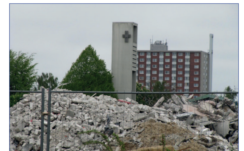
Jede Menge Schutt: Das abgerissene Einkaufszentrum.
