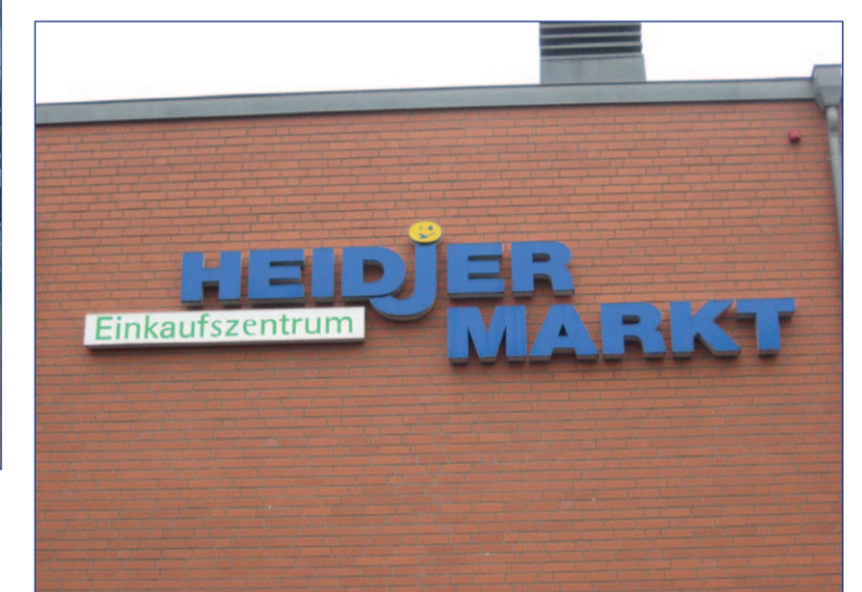
Ist nun Geschichte: der vorherige Backsteinbau des alten Einkaufszentrums.
